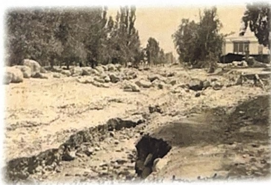
Рисунок 1.5 – Разрушения на нынешней улице им. Динмухамеда Кунаева
