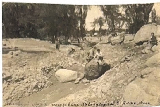
Рисунок 1.6 – Разрушения на Проспект им. Абая Кунанбаева
